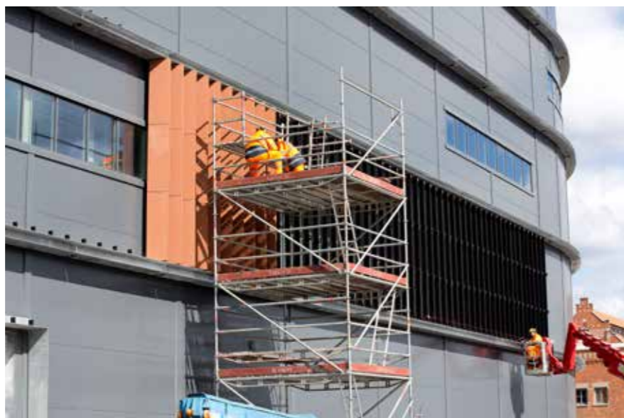
Byggepladsen ved KVV8, august 2014. Foto: Hans Ekestang.
