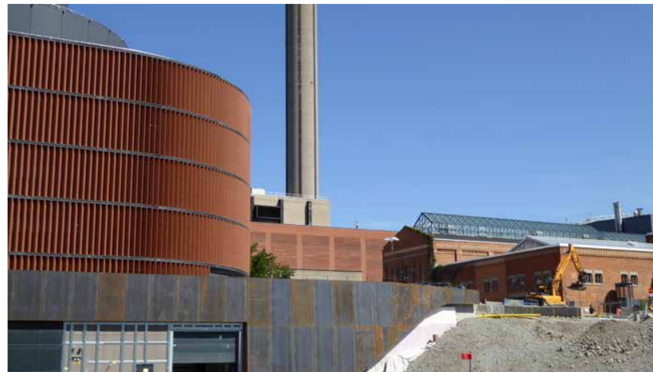
Det ydre, lette facadelag af terracottaelementer deler materiale med Värtaverkets murede bygningsbestand, men fortolkningen af teglet og af facadens rolle er nutidig. Foto: GPA.
