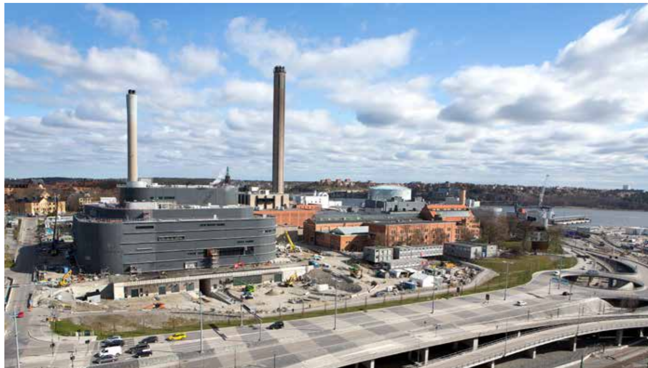
Värtaverket ligger i Hjorthagen i det centrale Stockholm. Brændsel til værket fragtes gennem en tunnel fra den nærliggende Värtahamnen. Fotografiet er fra før monteringen af det ydre facadelag. Foto: Hans Ekstang.
